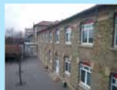
Façade SE Primaire
