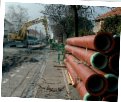
Suppression des branchements en plomb
